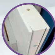
Structure consolidée par des renforts longitudinaux
