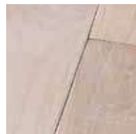
PA 14 plancher du boulanger
