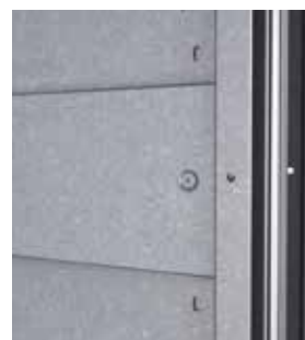
Repères de vissage plaques de plâtre
