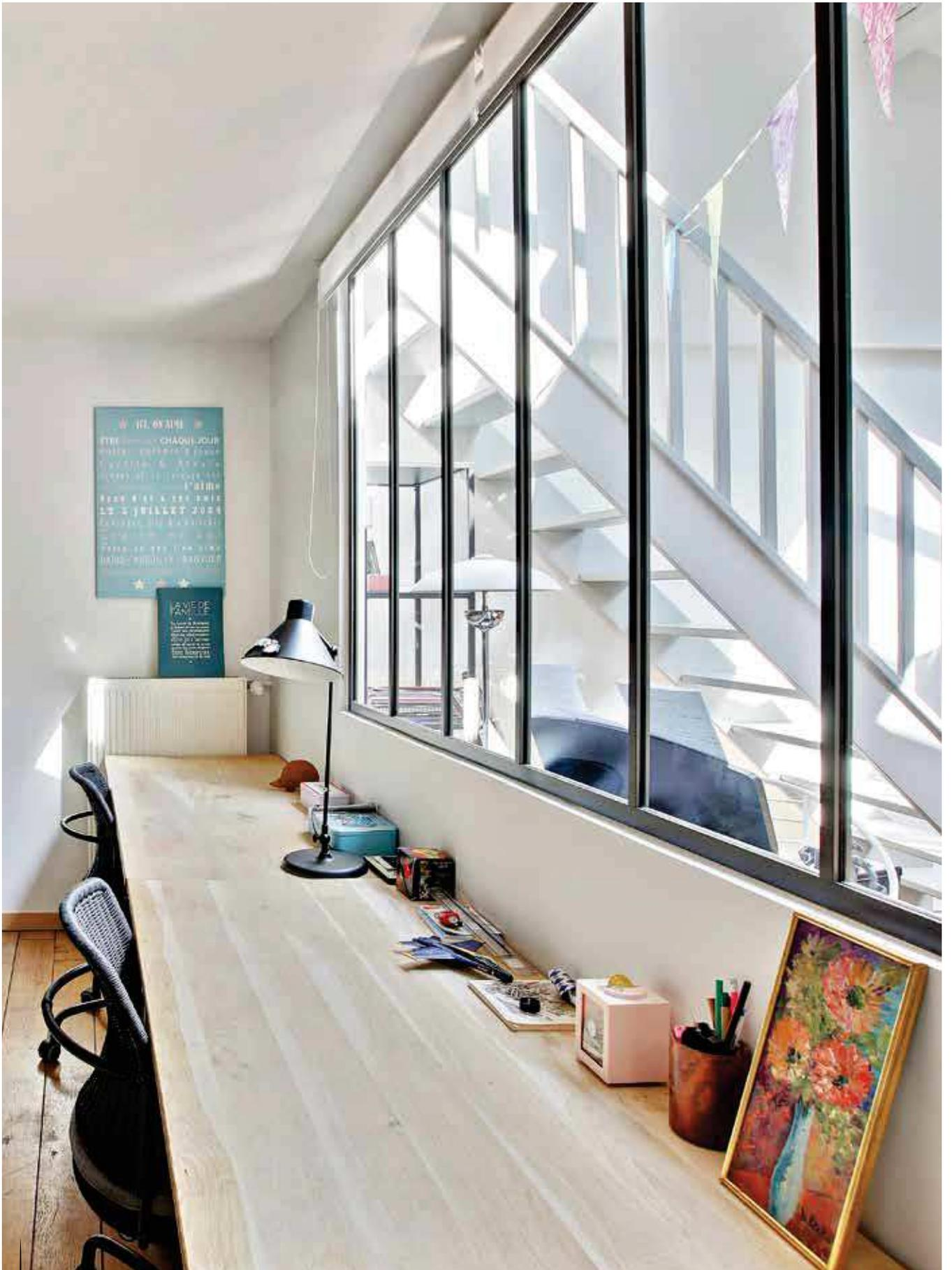
**Verrière avec pose invisible** vitrage clair - finition 9005 grainé
