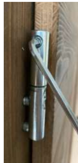
Réglage de la largeur
