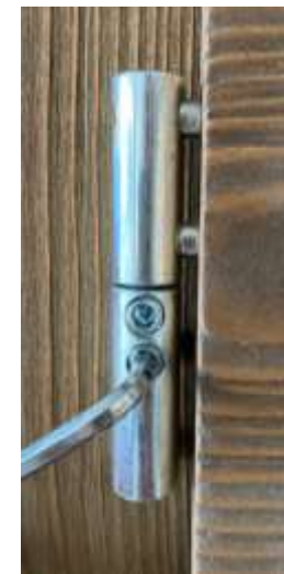
Réglage de la profondeur
